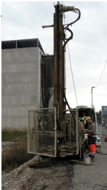
Forage en cours
