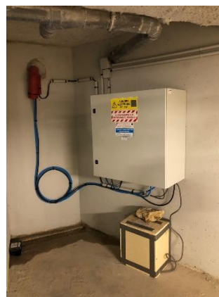
A gauche : installation en cours de l'armoire des équipements électroniques (vue des 2 numériseurs minimus) ; à droite : armoire fermée, avec au pied le capteur CMG 40, installé
