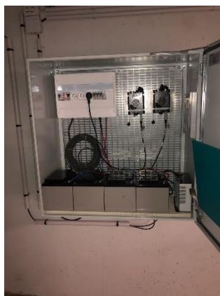
A gauche : installation en cours de l'armoire des équipements électroniques (vue des 2 numériseurs minimus) ; à droite : armoire fermée, avec au pied le capteur CMG 40, installé
