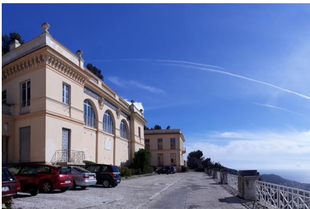
(source : cliché datant de mars 2018 © Madélnat Architecture)
